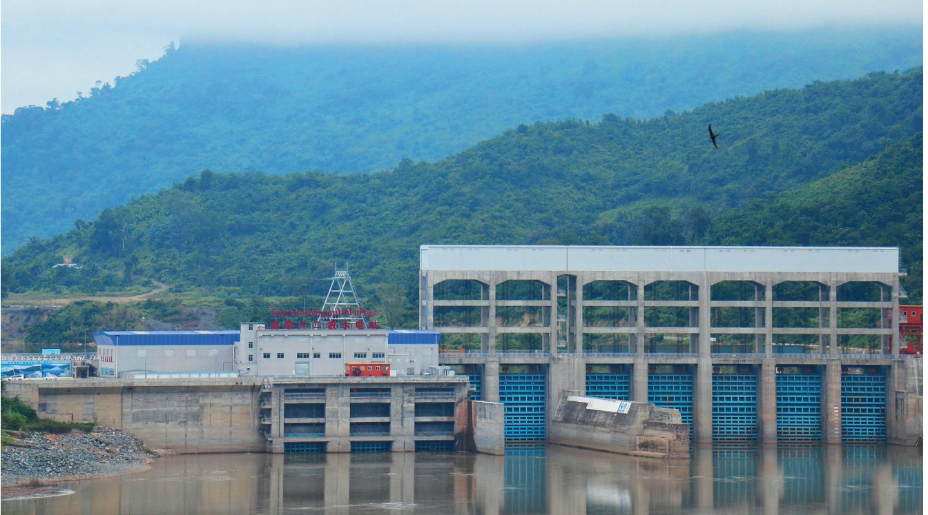
2016年12月12日在老挝琅勃拉邦拍摄的南欧江二级水电站。
